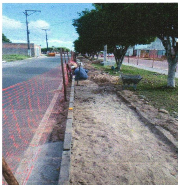
Foto 01 - ASSENTAMENTO DE GUIA (MEIO-FIO) EM TRECHO RETO, CONFECCIONADA EM CONCRETO PRÉ-FABRICADO, DIMENSÕES 100X15X13X20 CM (COMPRIMENTO X BASE INFERIOR X BASE SUPERIOR X ALTURA), PARA URBANIZAÇÃO INTERNA DE EMPREENDIMENTOS. AF_06/2016_P
